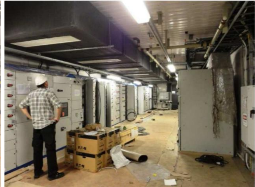
4. Switchgear room
